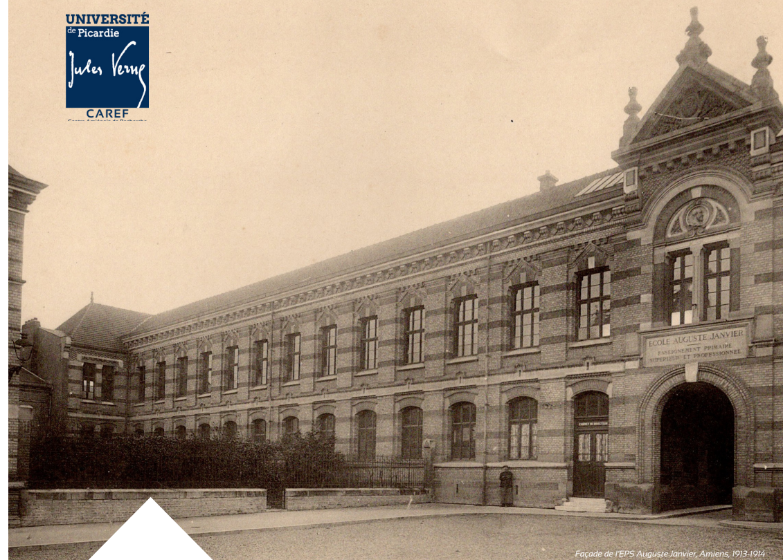
Façade de l'EPS Auguste Janvier, Amiens, 1913-1914
